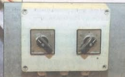
En halv/hel-kontakt sikrer den rette varme i hulerne og sparer samtidig strøm. (Foto: Anne Wolffenberg)
